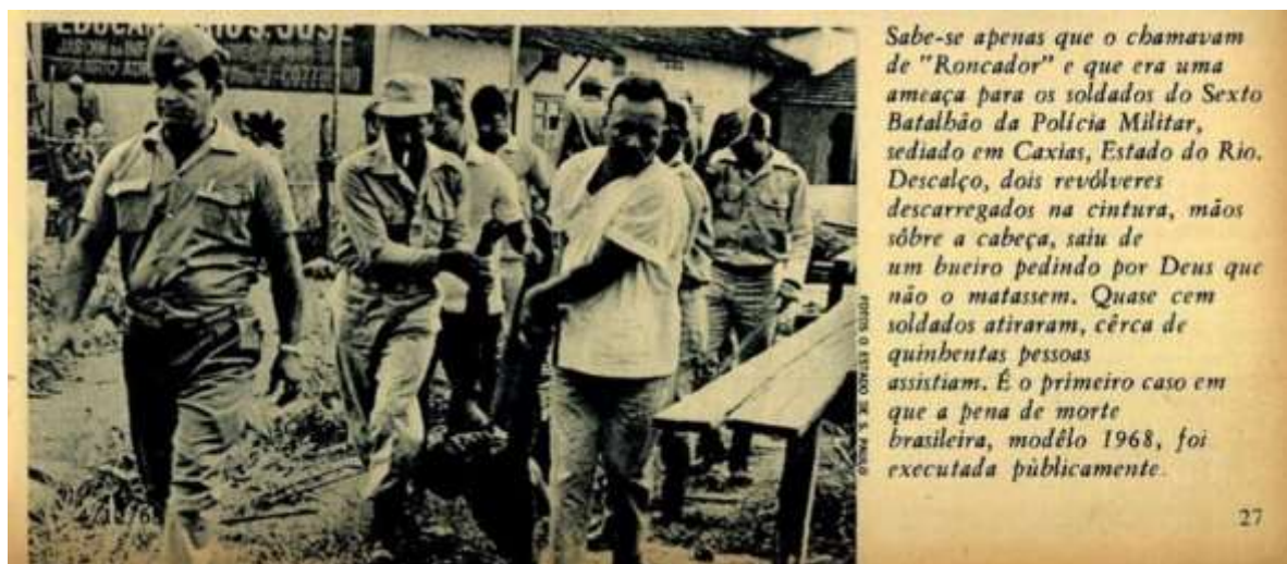
Figura n. 7 Corpo de Roncador sendo retirado do local.
