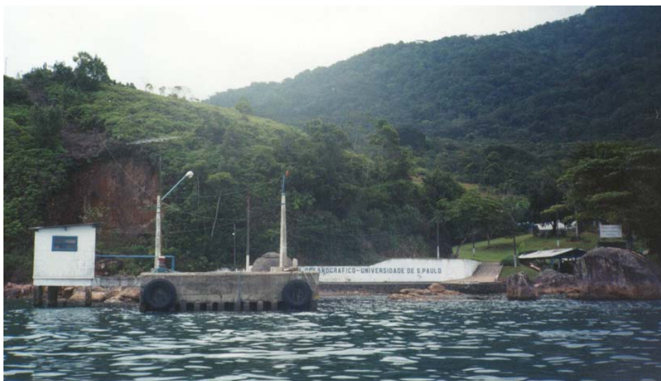
Figura 21 – Ponto 5 Ubatuba 23°30'04" S e 45°07'08" W
