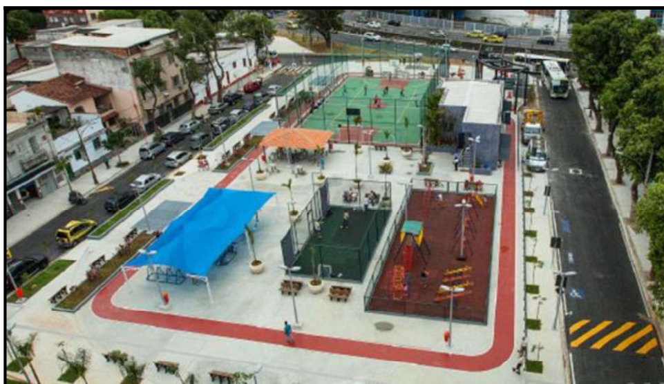
Figura 12 – Bacia de retenção da Praça Niterói/RJ, após urbanização.
