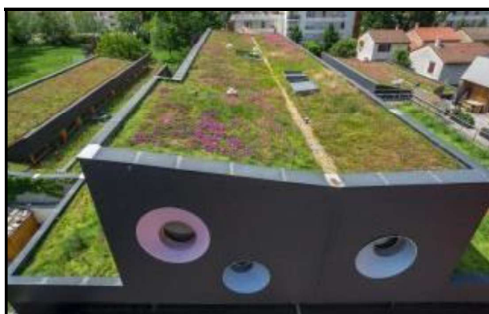
Figura 19 – Telhado verde extensivo
