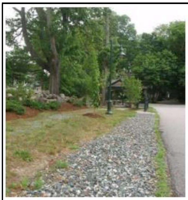
Figura 13 – Trincheira de infiltração
