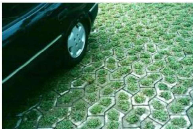
Figura 27 – Aplicação do bloco de concreto vazado em um estacionamento
