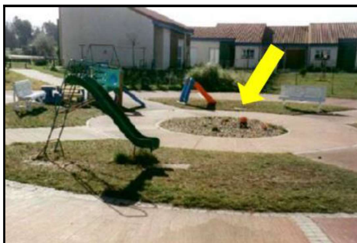
Figura 16 – Poço de infiltração em Lyon
