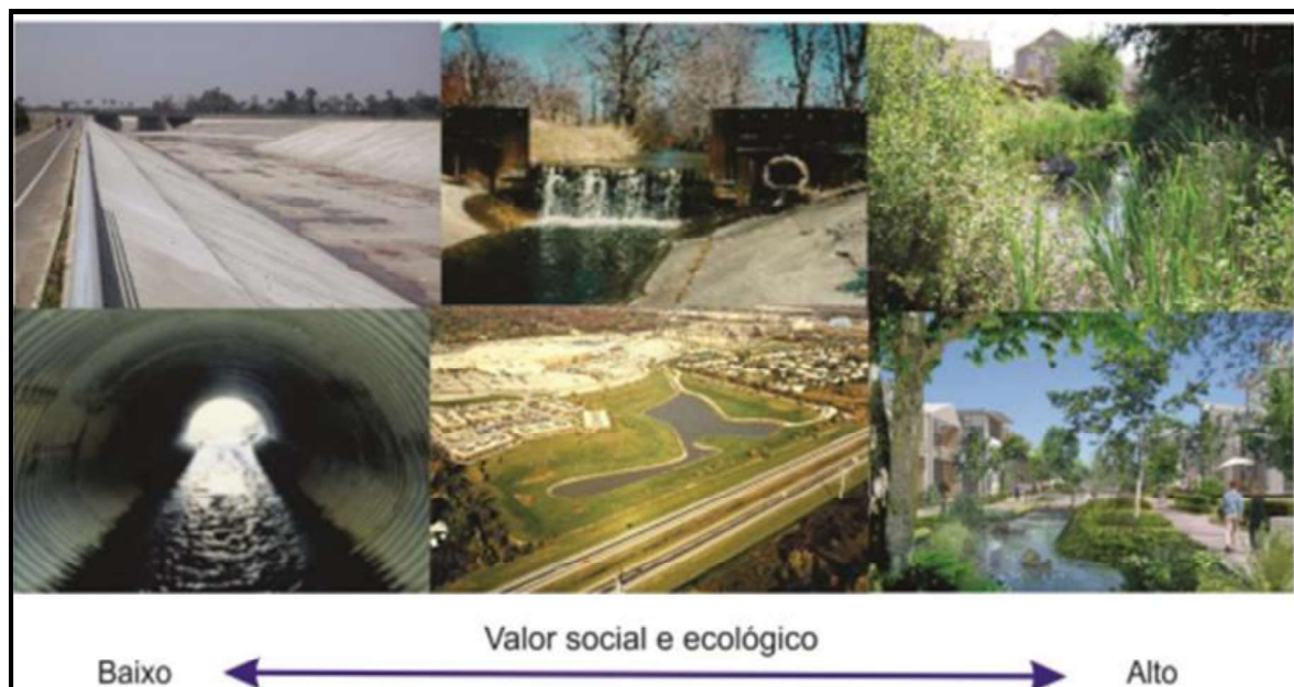
Figura 7 – Sistemas clássicos e sustentável de drenagem
