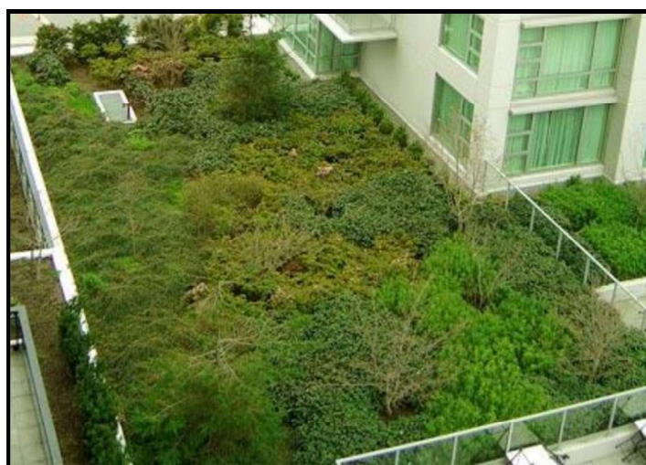
Figura 20 – Telhado verde intensivo
