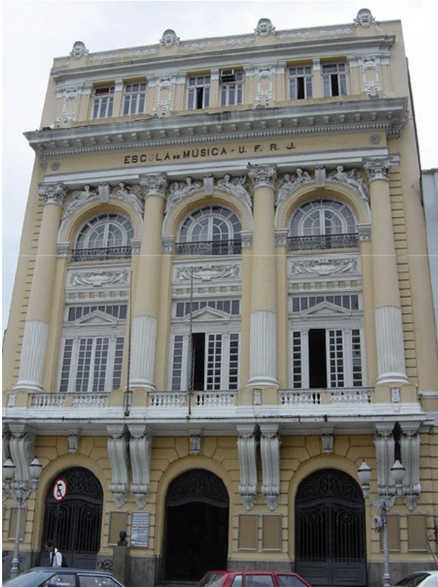
Figura 6 – Atual prédio da Escola de Música da UFRJ.
