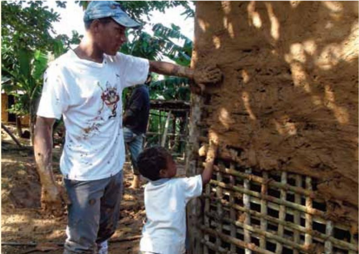
Cozinha de pau a pique sendo construída no Quilombo de Ivaporunduva. Foto: Douglas Mansur
