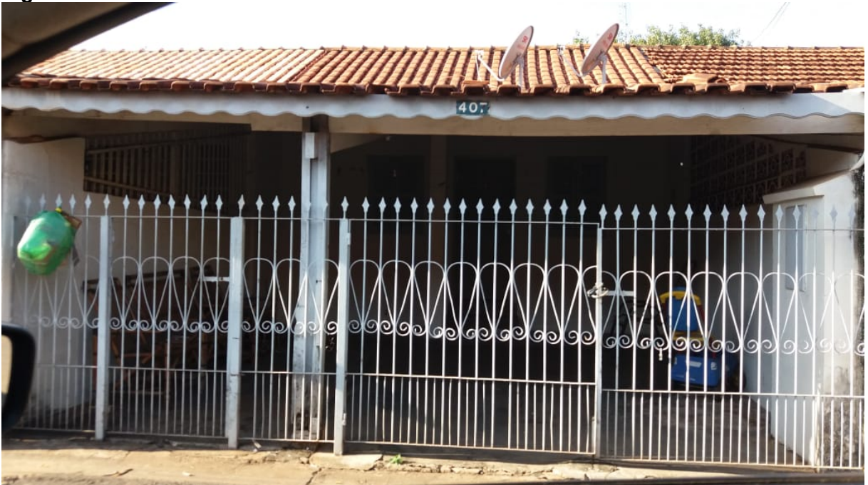
Figura 16 - Casa de alvenaria - Nível 1
