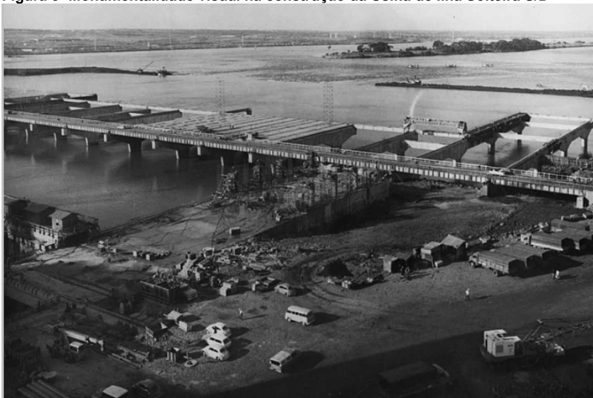
Figura 3 -Monumentalidade visual na construção da Usina de Ilha Solteira S/D
