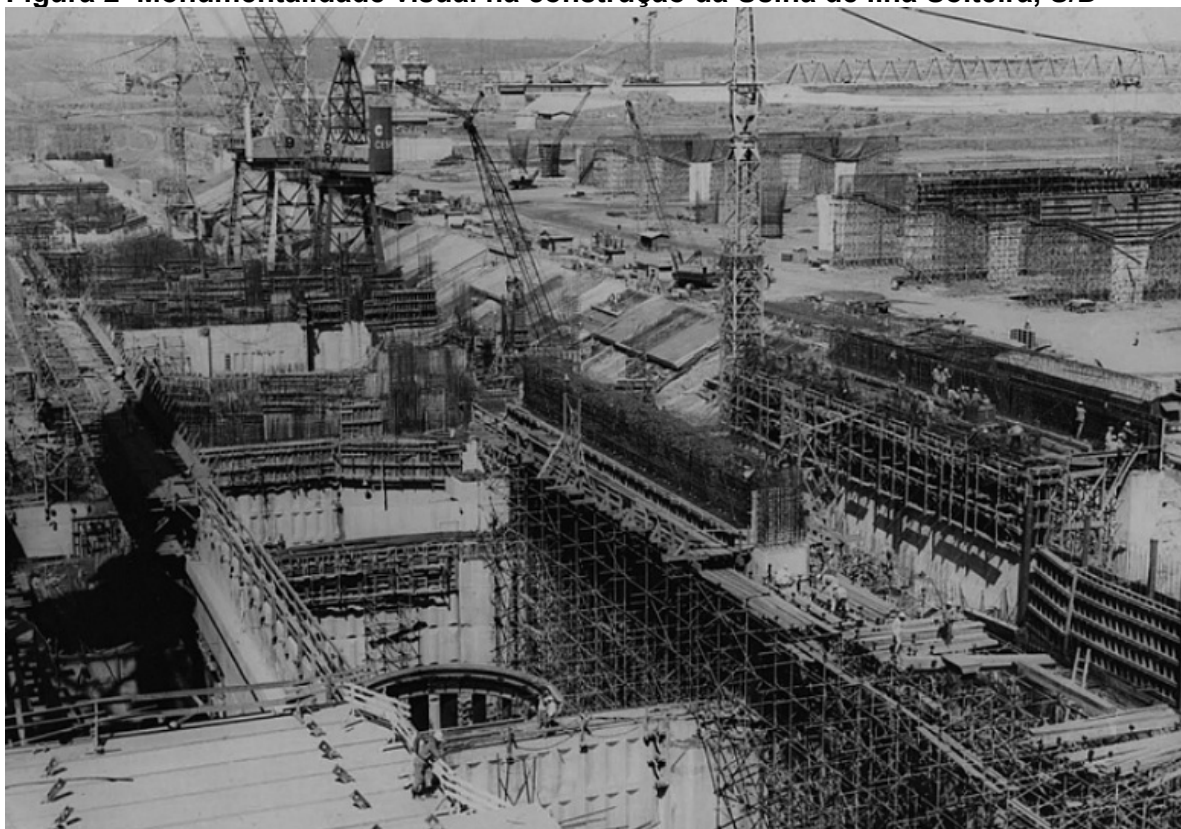
Figura 2—Monumentalidade visual na construção da Usina de Ilha Solteira, S/D
