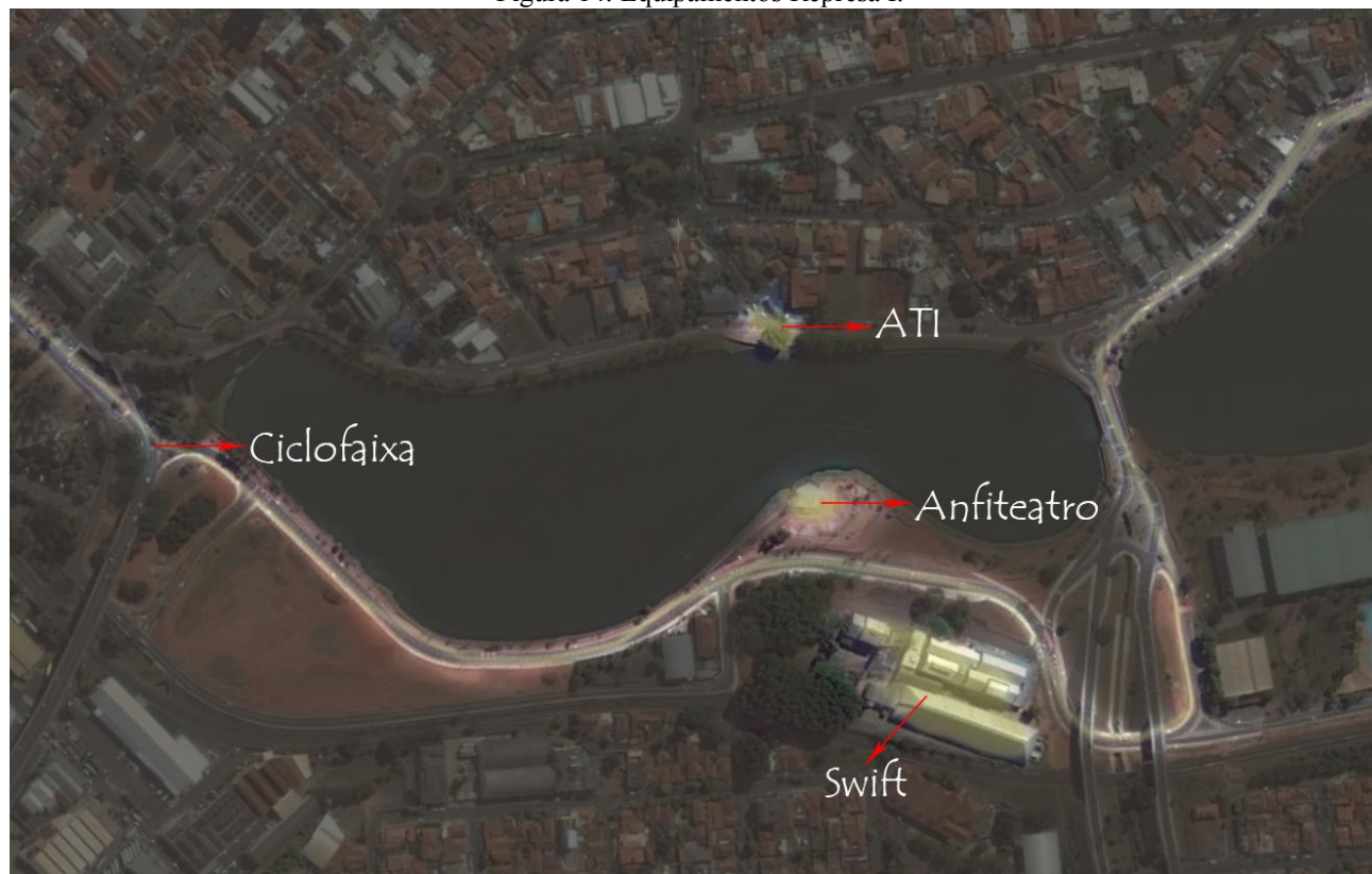
Figura 14. Equipamentos Represa I.
