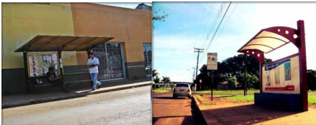
Figura 12. Pontos de parada com abrigo
