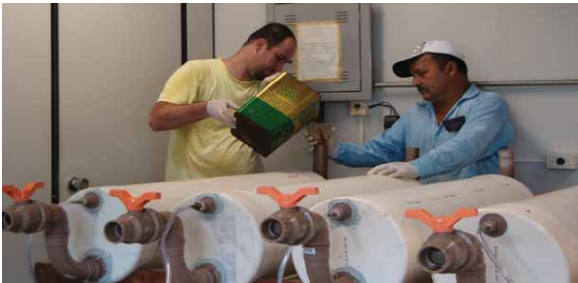
Figura 12. Abastecimento inicial dos biodigestores, com CFCSS + I.
