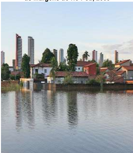
Foto 13 - Alagamento de Ruas e Avenidas às Margens do rio Poti, 2009
