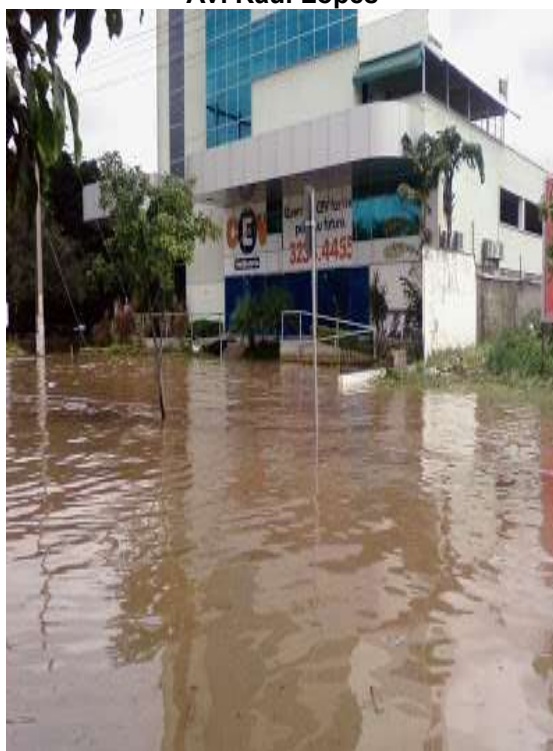
Foto 2 - Enchente no bairro Jóquei Clube - Av. Raul Lopes
