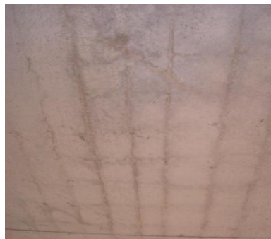
Figura 5.16 - Adensamento Adequado (Fonte: http://www.multiquip.com.br ).
