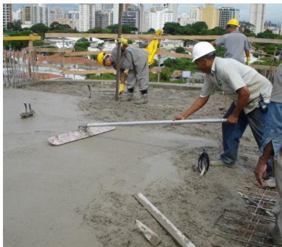
Figura 5.23 – Sarrafeamento da Laje (Fonte: www.abesc.org.br ).
