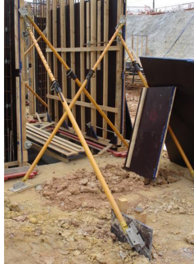
Figura 4.2 - Aprumador Metálico com Regulação Milimétrica (Fonte: Especificação Técnica Gafisa, 2011 – Cimbramento, pág.32).
