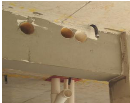
Figura 5.13 - Passantes nas Vigas Executado de Forma Correta (Fonte: http://www.multiquip.com.br ).
