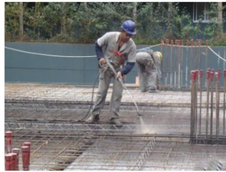
Figura 5.19 - Lavagem com Hidro-Jato (Fonte: www.abesc.org.br ).
