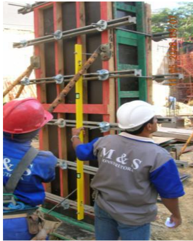
Figura 5.21 Utilização da Régua Técnica (Fonte: www.abesc.org.br ).
