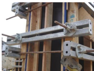
Figura 4.1 – Barra de Ancoragem + Porca Borboleta + Sanduíche Metálico (Fonte: http://www.aecweb.com.br/barras-de-ancoragem/barra-de-ancoragem-e-porca-flangeada ).
