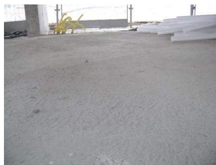
Figura 5.6 - Acabamento Superficial do Piso Executado de Forma Correta (Fonte: http://www.multiquip.com.br ).
