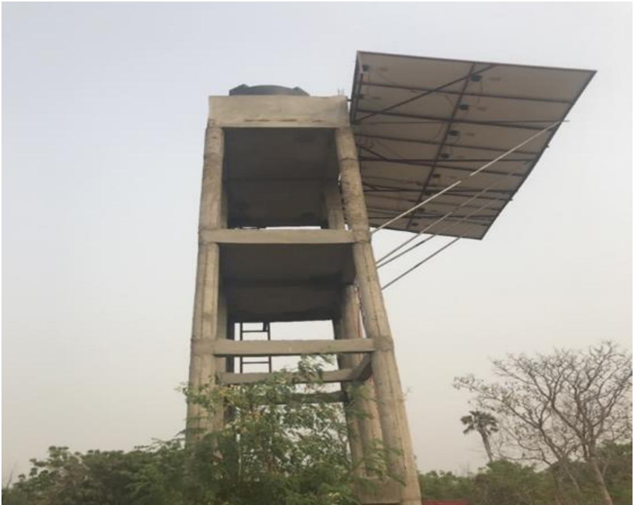
Figura 21: Torre de distribuição de água no distrito de Kéré
