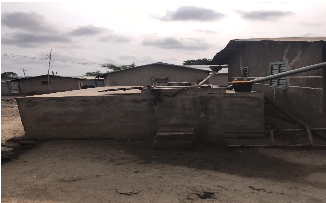
Figura 7 : Cisterna de armazenamento de água.
