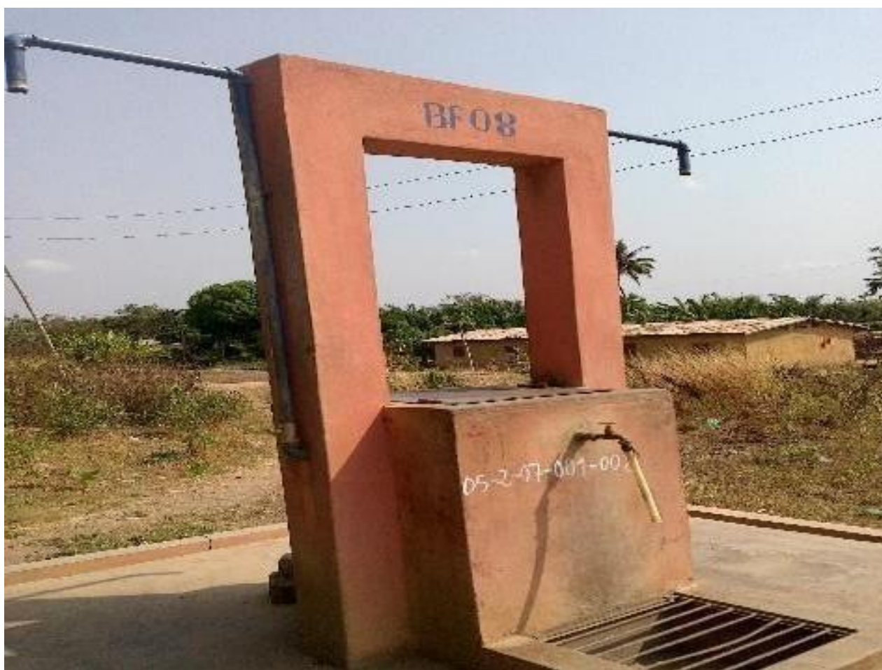
Figura 22: ponto de abastecimento de água potável criado pela comunidade Kéré
