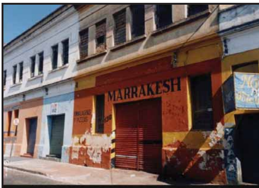
Fig. 66 – Vista parcial das edificações na Rua José Bonifácio
