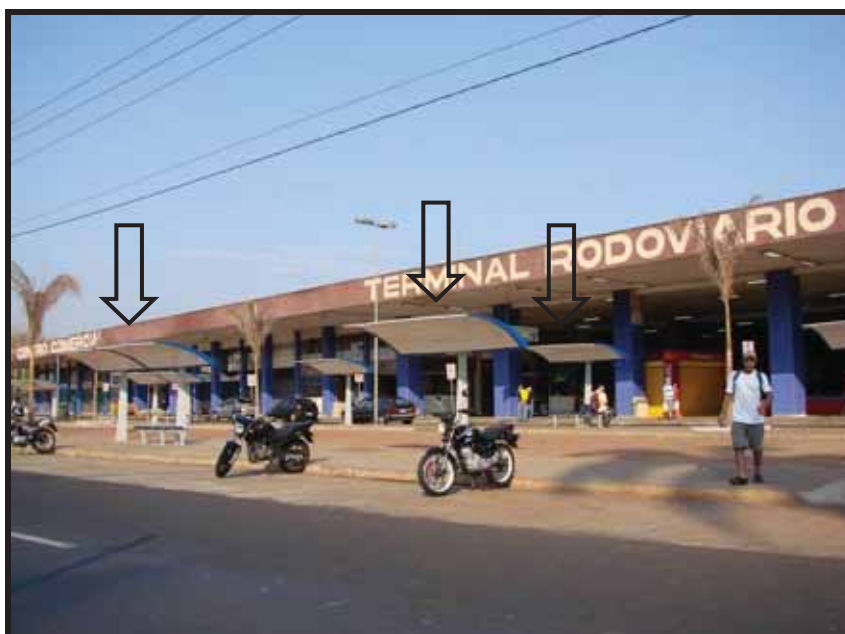
Fig.61 – Novos locais de espera de ônibus urbano construídos na Avenida Jerônimo Gonçalves.
