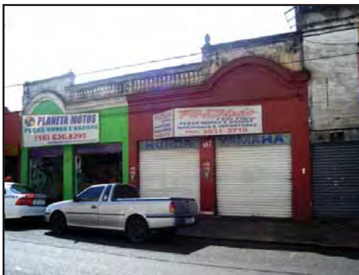
Fig. 55 - Vista parcial das edificações da Rua José Bonifácio
