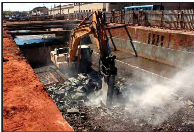
Fig. 65 – Obras no ribeirão Preto, 2010.
