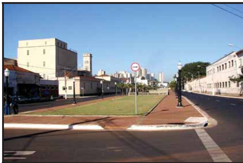
Avenida Jerônimo Gonçalves após as obras antienchentes. Vista da Avenida no cruzamento da com a Avenida Francisco Junqueira. Foto: Débora Lopes Francisco, 2011.
