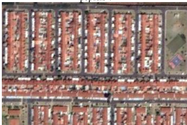
Figura 12: Araçatuba. Terra Nova e Moradas. Padrão de construção de “característica popular”.
