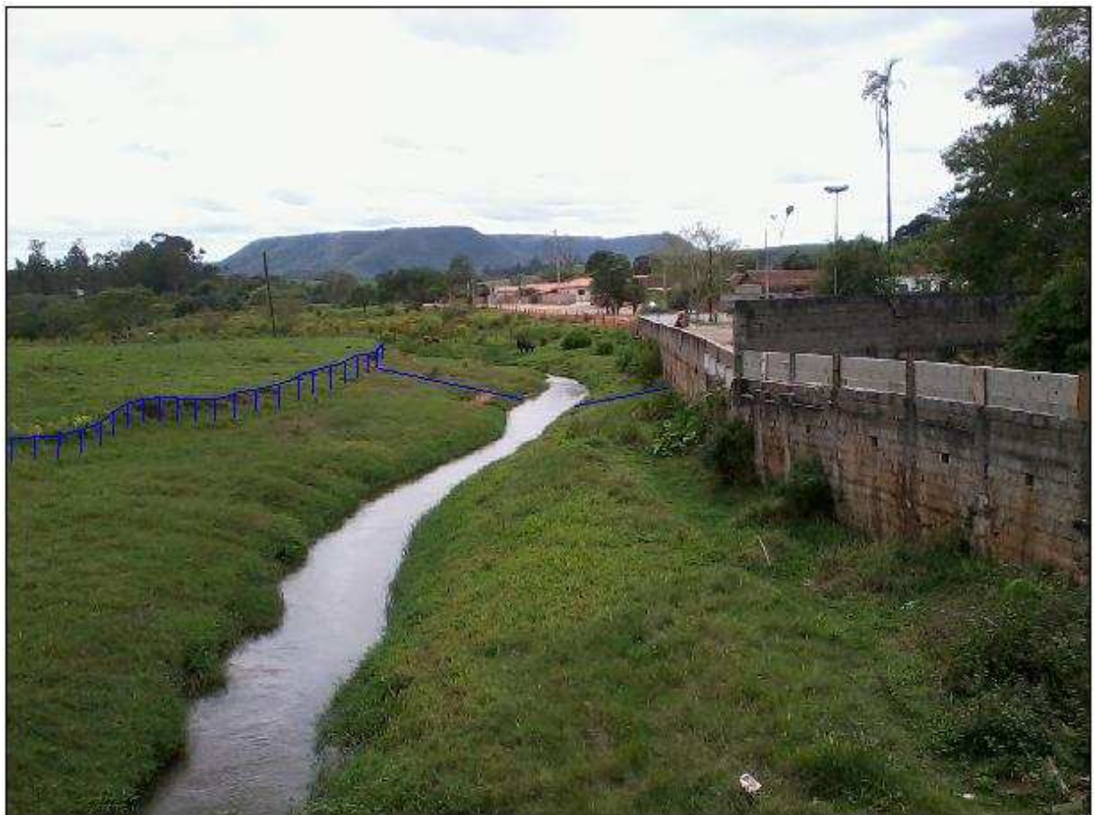
Foto 09 – Construções muito próximas da margem esquerda do Ribeirão Bonito na entrada da cidade de Santa Maria da Serra - SP Fonte: AGUIRRE, F. Z. (2010)
