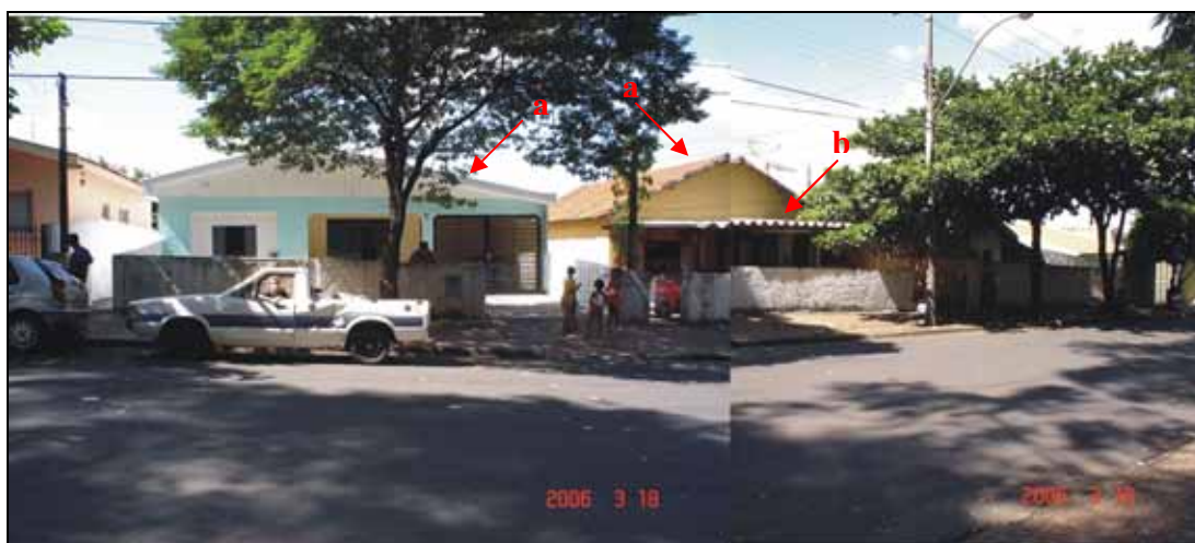
Residências com vários tipos de coberturas: a) telhados de cerâmica b) Prolongamento de amianto.
