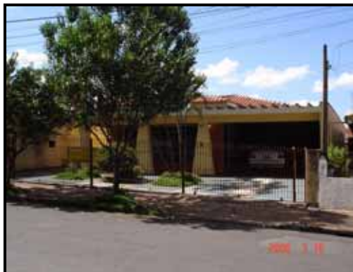
Empresa em atividade. A maior parte do telhado é de cerâmica, mas a parte frontal é de amianto
