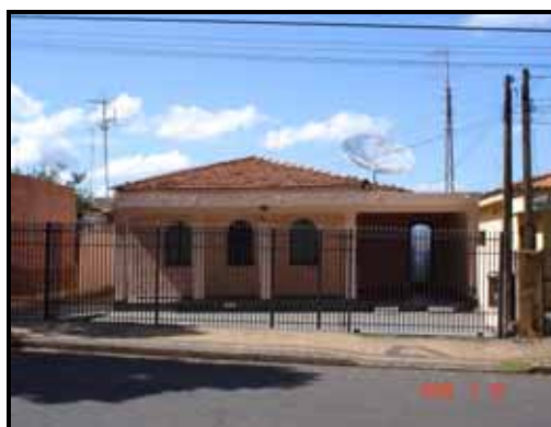
Residência com a maior parte do telhado de cerâmica. Apenas a frente é de amianto.
