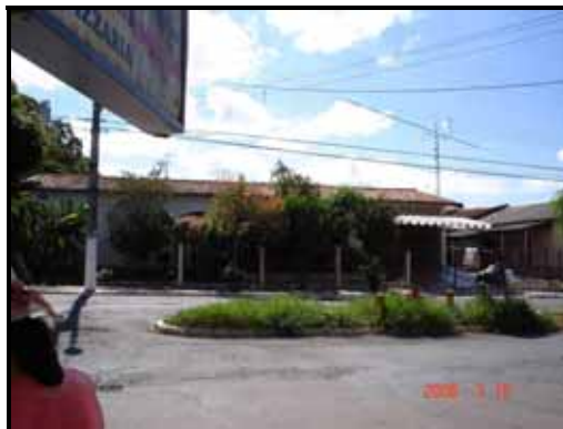
Residência com telhado de cerâmica (escuro) e um prolongamento de amianto
