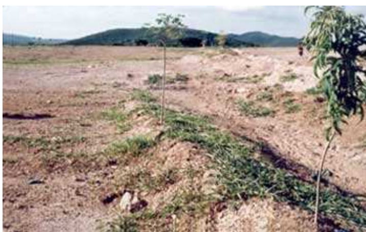
Figura 04 – Aspecto visual de um aterro controlado (PMPM/SMMAA, 2007)
