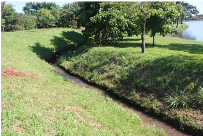
Figura 11. Canalização do rio Araquazinho (751963m de longitude e 7491336m de latitude).
