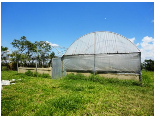
Figura 2. Vista externa da estufa para o setor de crescimento.
