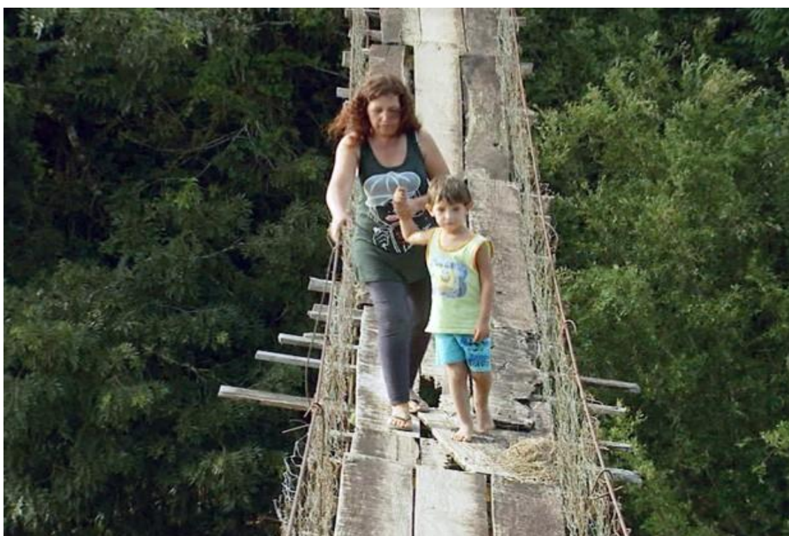
Ponte improvisada que liga os bairros Serra do Paraíso e Terra Preta. Fonte: EPTV Sul de Minas.
