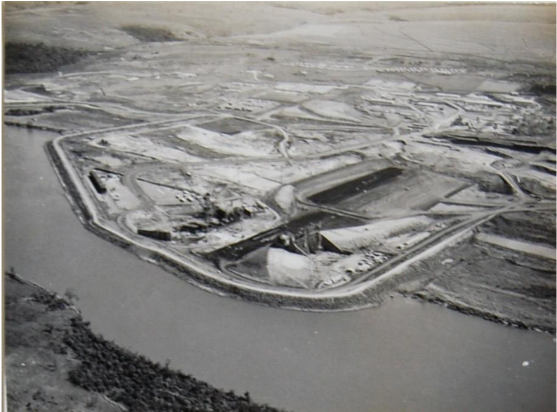
Figura 6: UHE Capivara em construção. Obra principal.
