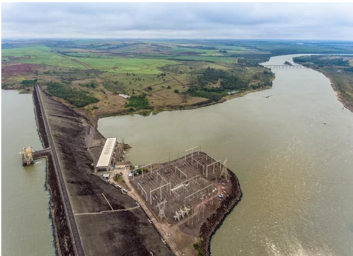
Figura 20: Vista geral da área do Lago e da ponte que foi submersa.
