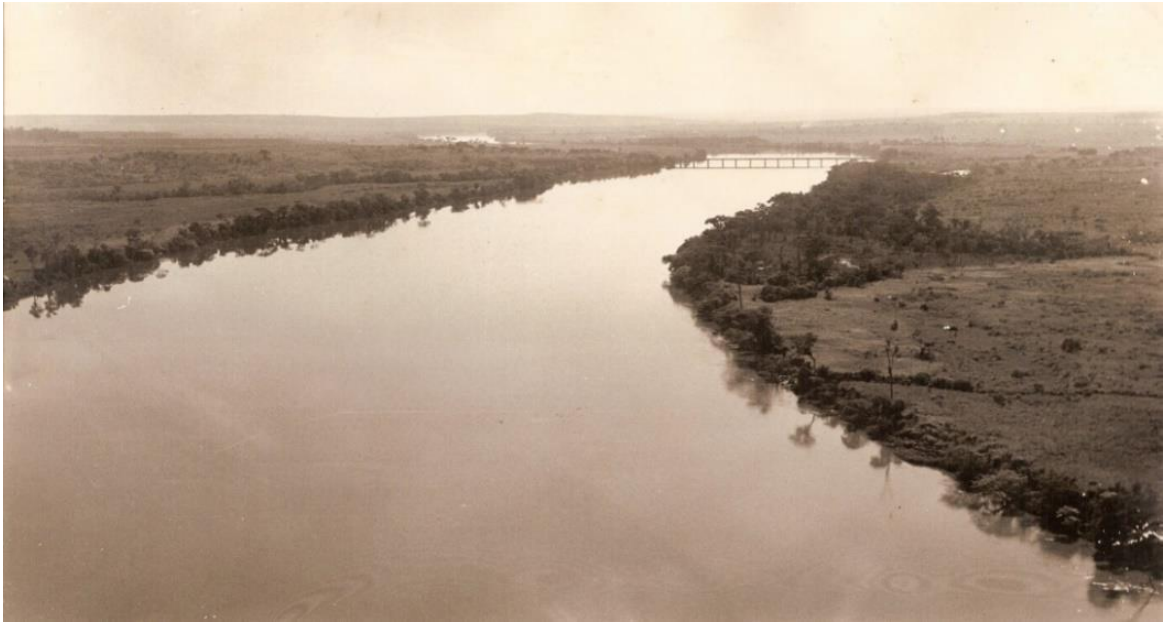
Figura 14: Ponte lepê – Alvorada, antes da inundação.
