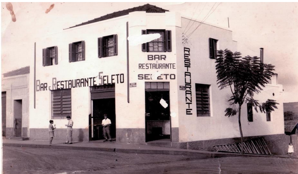
Figura 65: Primeiro Prédio do Museu de Arqueologia de Iepê.
