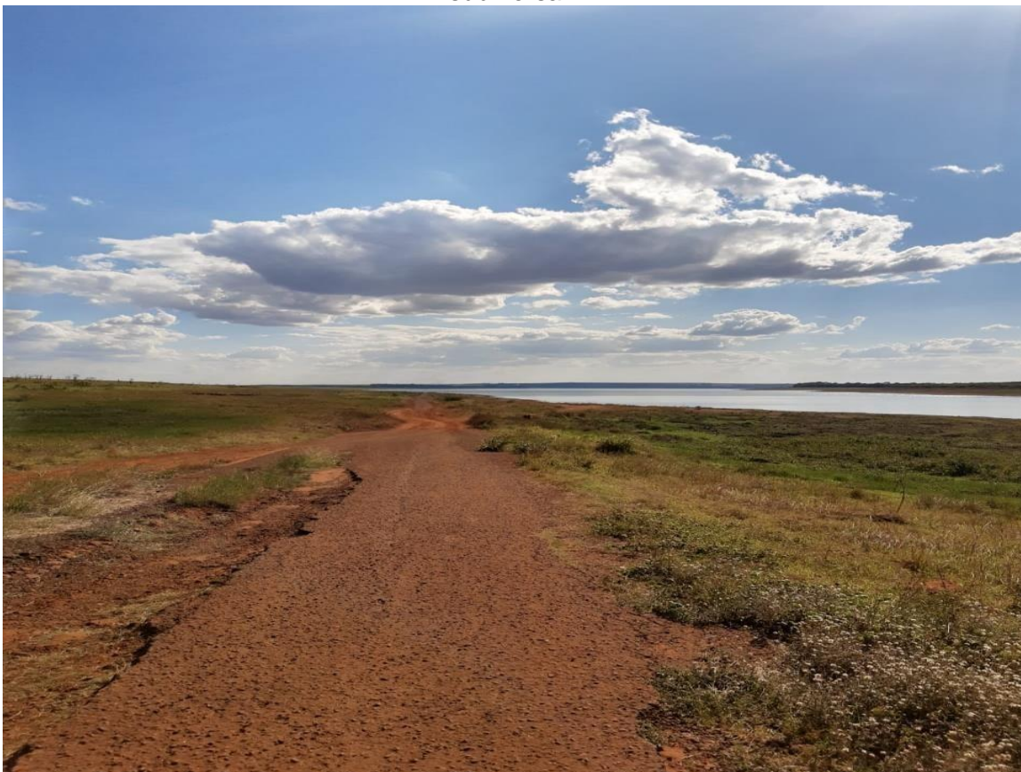
Figura 16: Lago da UHE onde ficava a ponte Iepê-Alvorada. Ponte totalmente submersa.
