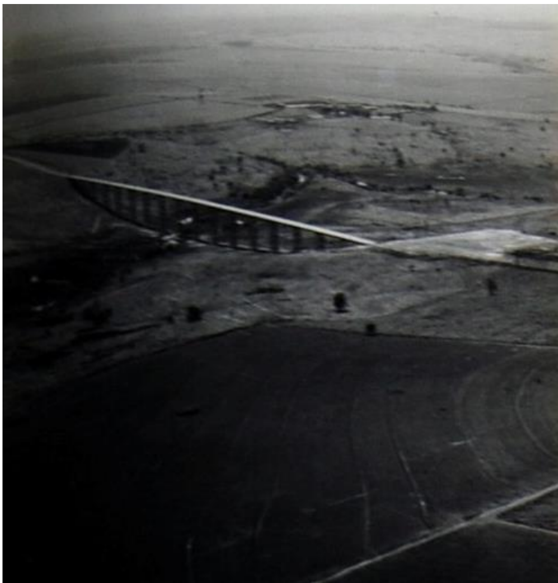
Figura 13: Ponte Iepê-Alvorada, antes da inundação.
