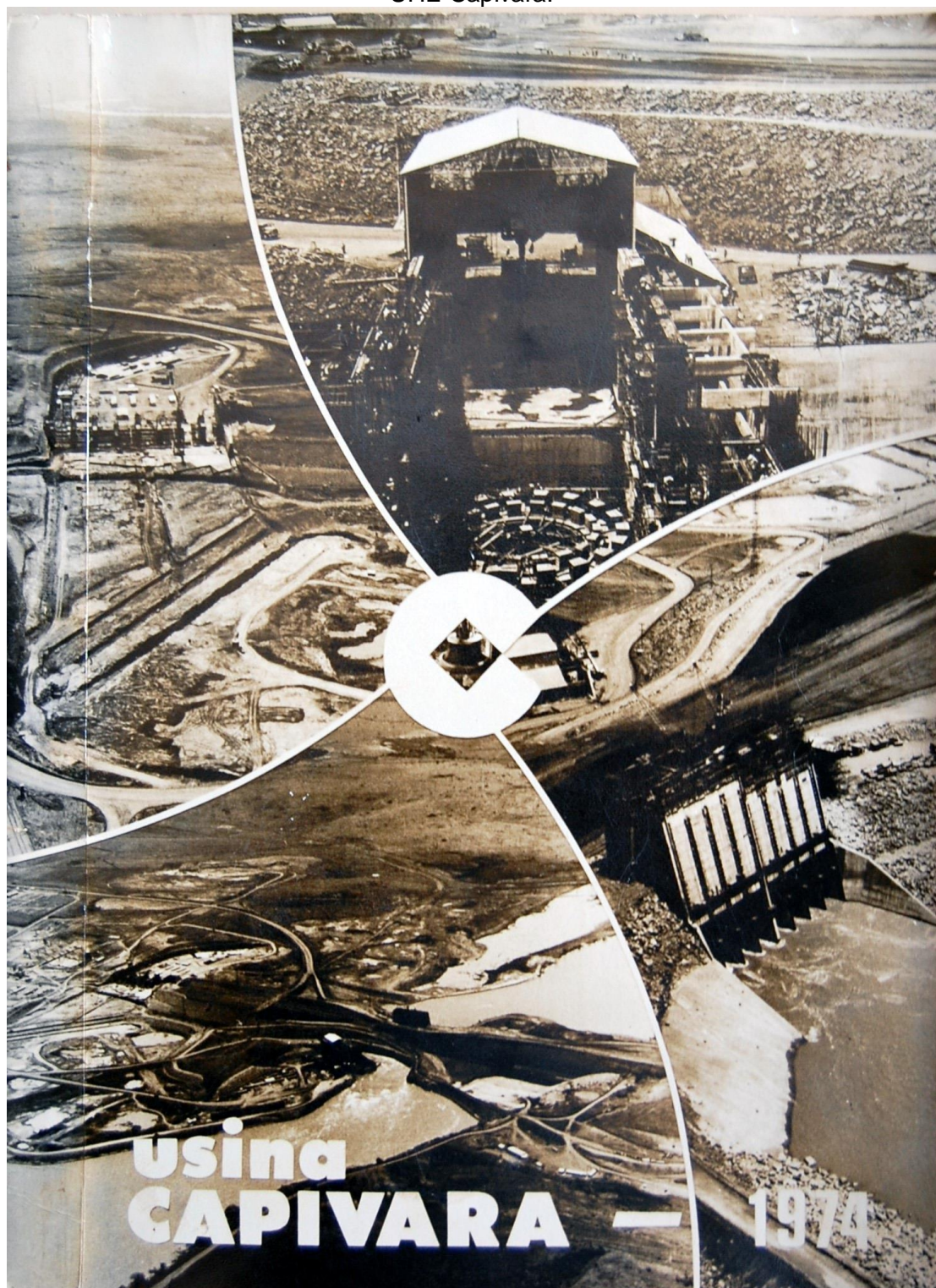
Figura 12: Montagem das Turbinas tipo Francis. UHE Capivara.
