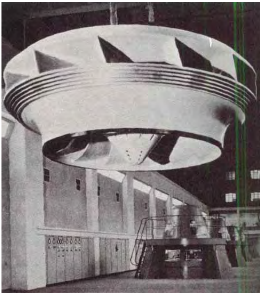
Figura 2.11- Rotor de uma turbina Francis
