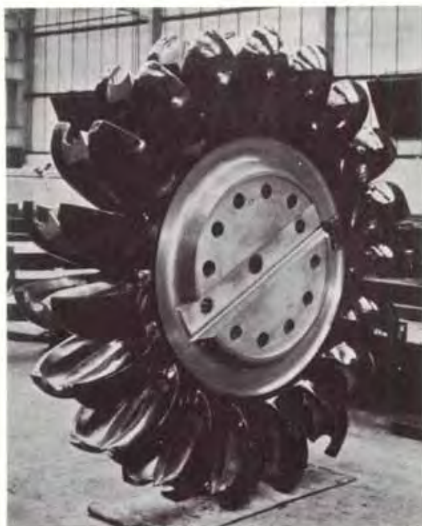
Figura 2.5- Rotor de turbina Pelton
