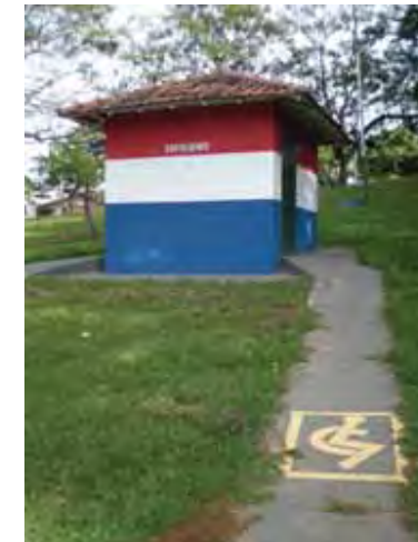
Figura 15: Banheiro para portadores de deficiência recentemente implantado (detalhe para sinalização no piso).
