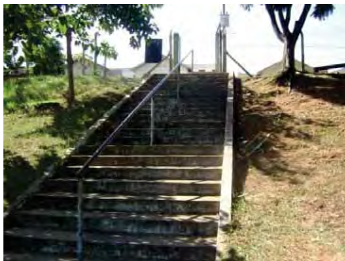
Figura 26: Portão 3 pela Rua das Sibipirunas: lance de escada sem patamar para vencer o talude.
