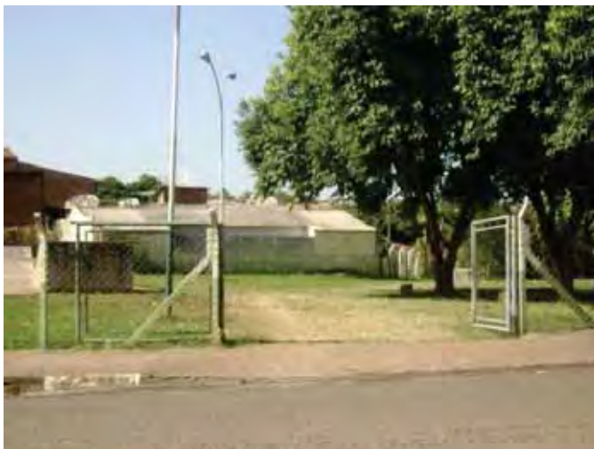
Figura 30: Portão 7: acesso em nível para as pistas de skate. Esquina Rua João Ceribelli Pacca com Rua Otorino Parizzi.
