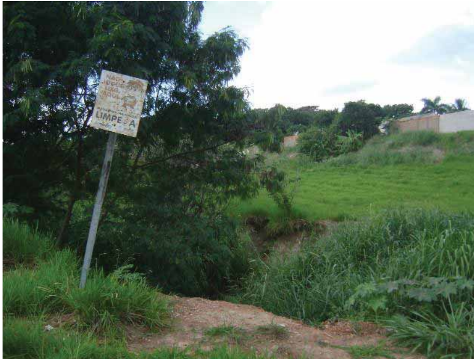
Figura 16: Imagem do trecho da área norte do fundo de vale. Em segundo plano, fundos das residências presentes.
