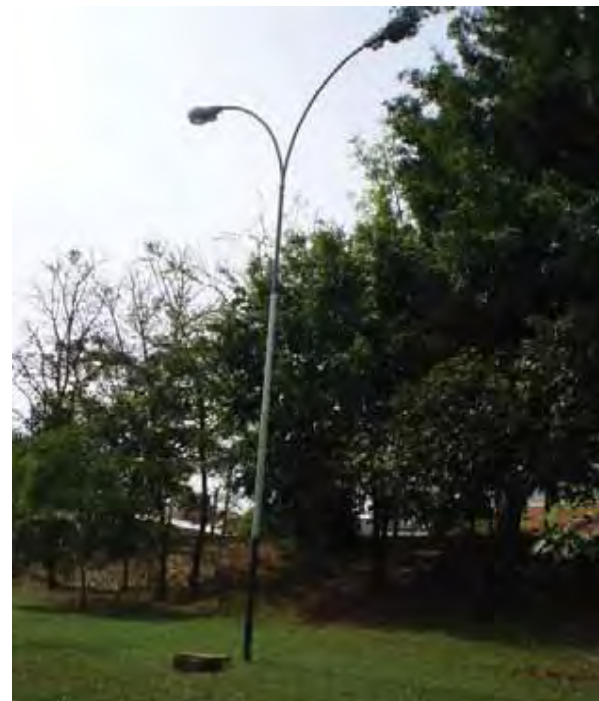
Figura 11: Poste de luz padrão do local.
