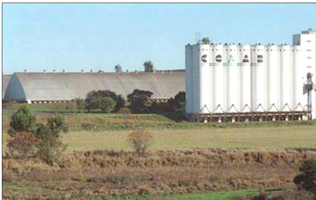
Foto 5 – Vista parcial dos armazéns da CONAB em Rondonópolis
