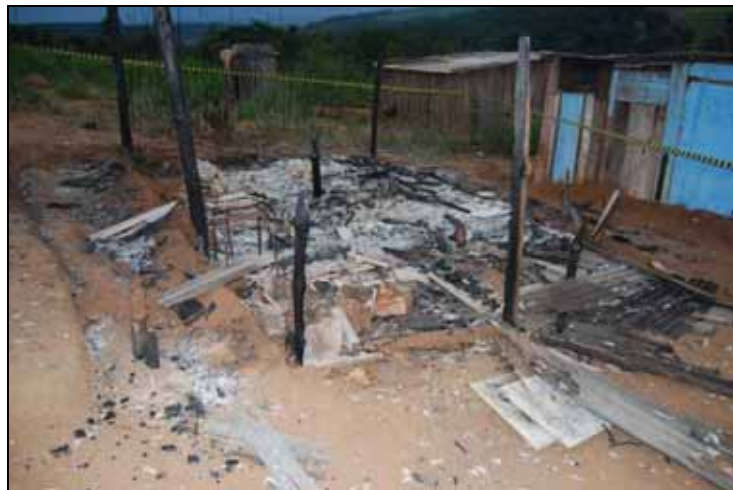
Figura 9 - Padrão de queima observado em pilares. Fonte: Próprio Autor (2009)
