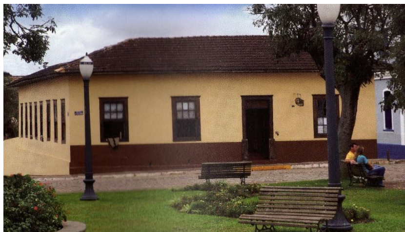
FIGURA 48 – Casa nº 6 da Praça Sant’Ana do Iapó
