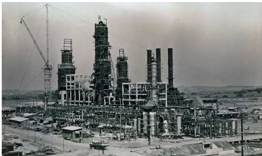
Figura 4 - Construção da REPLAN (Refinaria do Planalto em Paulínia)
