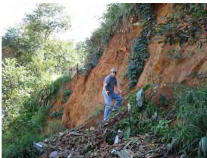
Figura 88: Escorregamento em área de ocupação irregular (MESQUITA, 2010).
