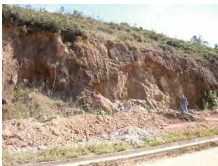
Figura 90: Deslocamento em abertura de arruamento (MESQUITA, 2010).
