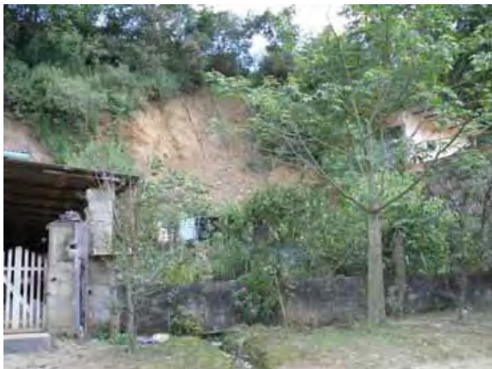
Figura 68: Área de declive com ocupação inadequada (MESQUITA, 2010).
