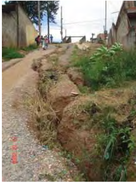
Figura 40: Processos erosivos do tipo ravinamento (SATO, 2006).
