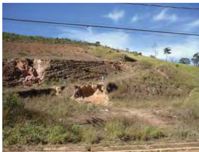
Figura 94: Escorregamentos e ravinamentos em áreas de empréstimo (MESQUITA, 2010).
