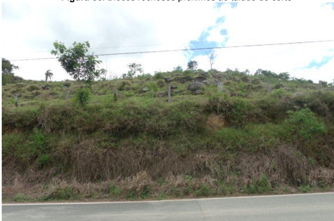
Figura 36. Blocos rochosos próximos ao talude de corte
