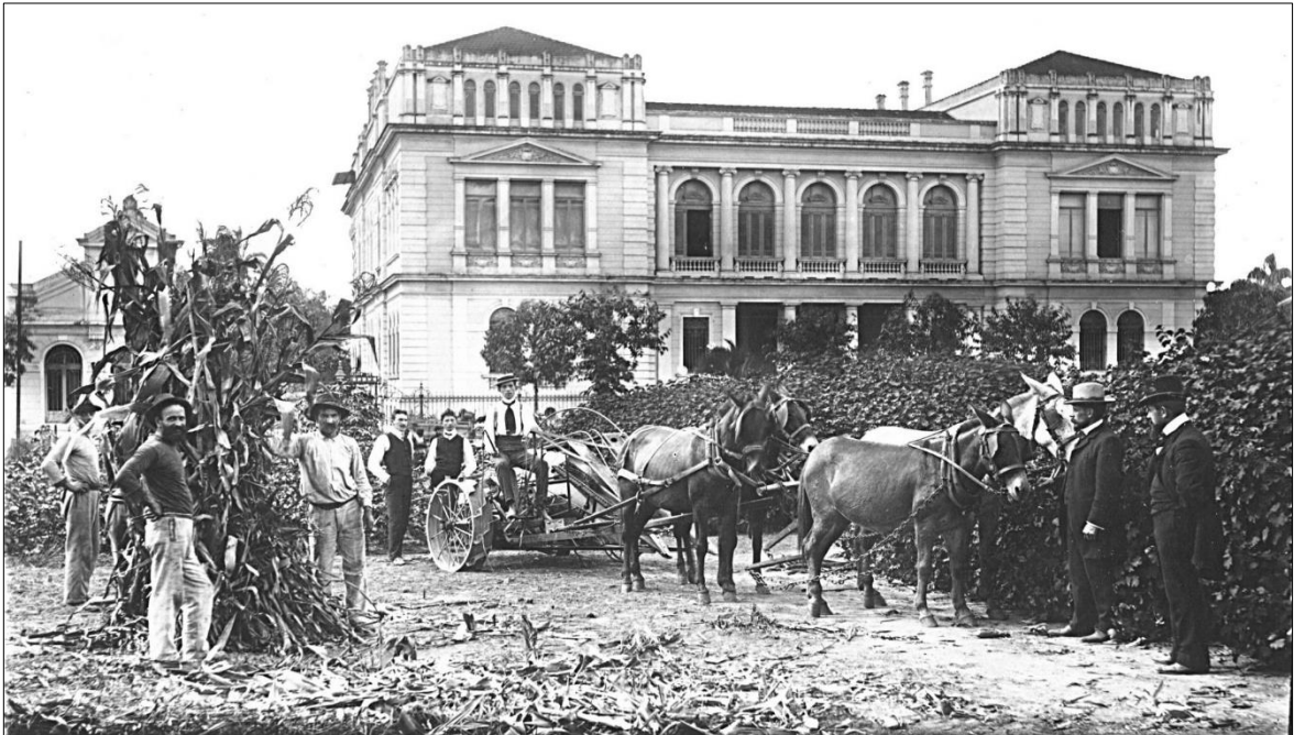
Figura 2 - Prédio que abrigou a sede da Poli (1893), depois Centro Estadual de Educação Tecnológica
