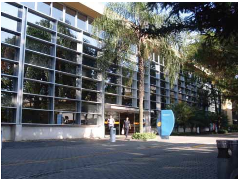
Figura 23: fachada principal da Biblioteca do SENAC campus Santo Amaro Fonte: arquivo pessoal, 2011.
