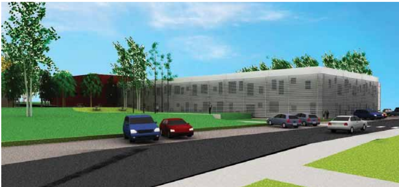
Figura 62: Entrada adjacente ao campus.
