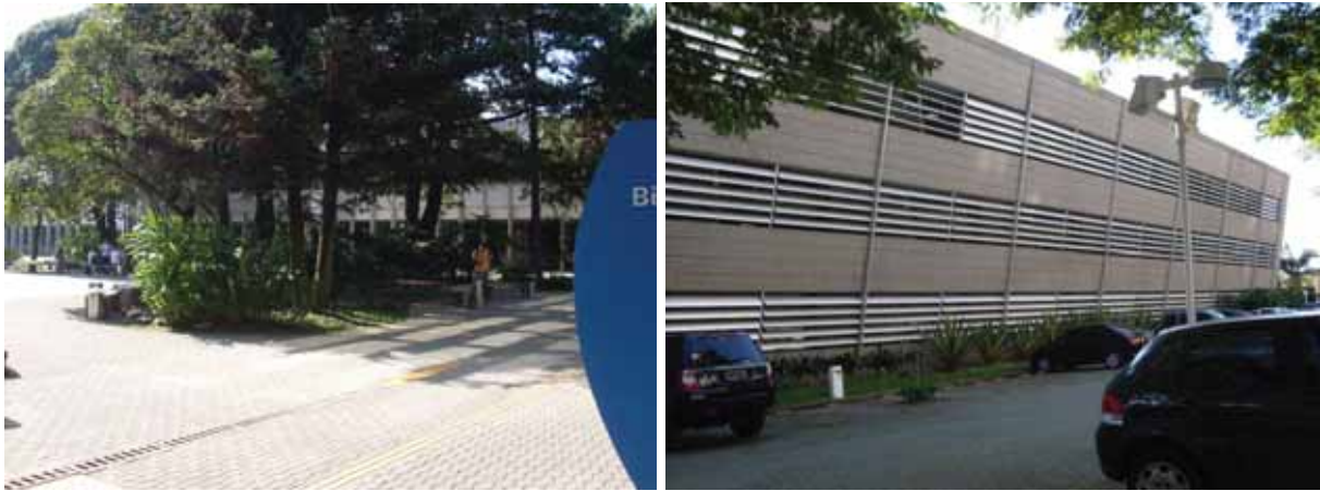
Figuras 24 e 25: praça interna do campus e fachada inclinada. Fonte: arquivo pessoal, 2011.
