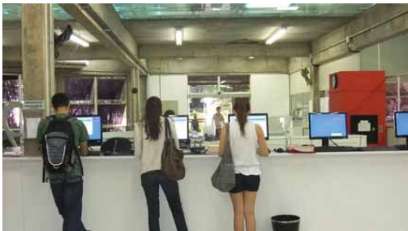
Figuras 6: Entrada principal: únicos computadores disponíveis para acesso no pavimento superior e acima iluminação natural modificada e não funcional.
