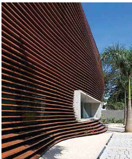
Figura 52: Empacotamento sombreador com brises horizontais.
