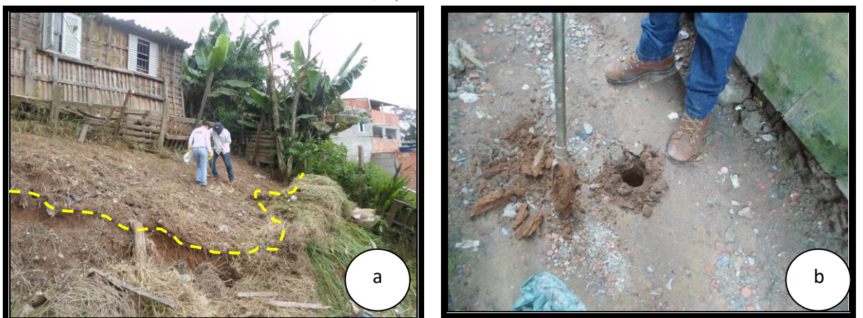
Figura 30 - Coleta de amostras na baixa vertente ou sopé da encosta, lados A e B, respectivamente: a) destaque para degrau de abatimento no solo (linha pontilhada) - amostra 01; b) amostra 05
