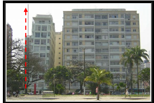
Figura 15 - Recalque por compressibilidade em Santos, Brasil
