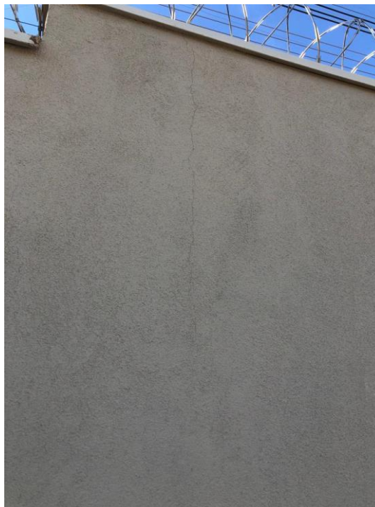
Figura 6 – Fissura Geométrica
