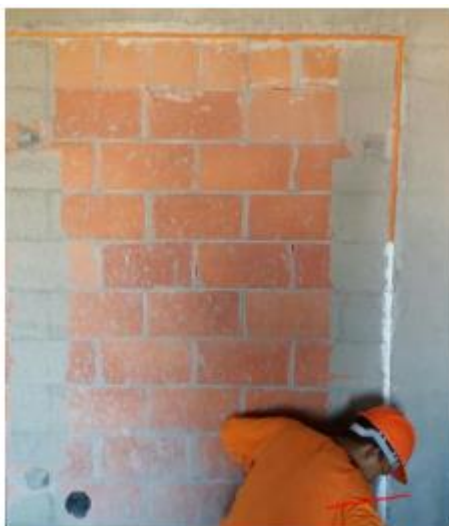
Figura 43 – Procedimento para prevenção de fissuras
