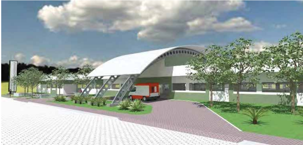
Figura 61 – Fachada frontal, com destaque para a cobertura da entrada de emergência
