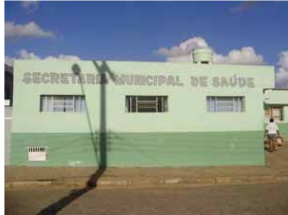
Figura 27 – Secretaria de Saúde em pequeno espaço no interior do Hospital.
