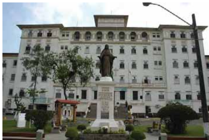
Figura 9 – Atual fachada do Hospital da Santa Cruz da Misericórdia de Santos.
