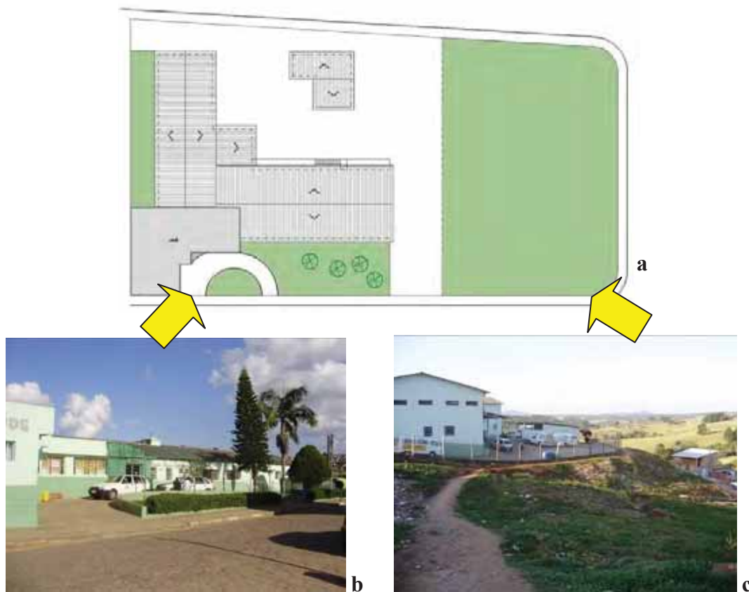
Figura 18 (a, b, c) – Implantação do Hospital , fachada principal esquerda e terreno sem uso ao lado do Hospital.
