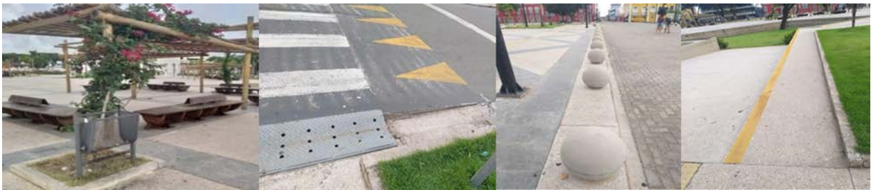
Figura 30 – Mobiliário, placas metálicas, balizadores e desnível não sinalizado na Deodoro
