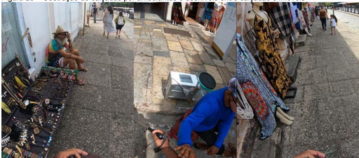
Figura 23 – Obstrução de calçadas por ambulantes e desníveis entre calçadas e imóveis
