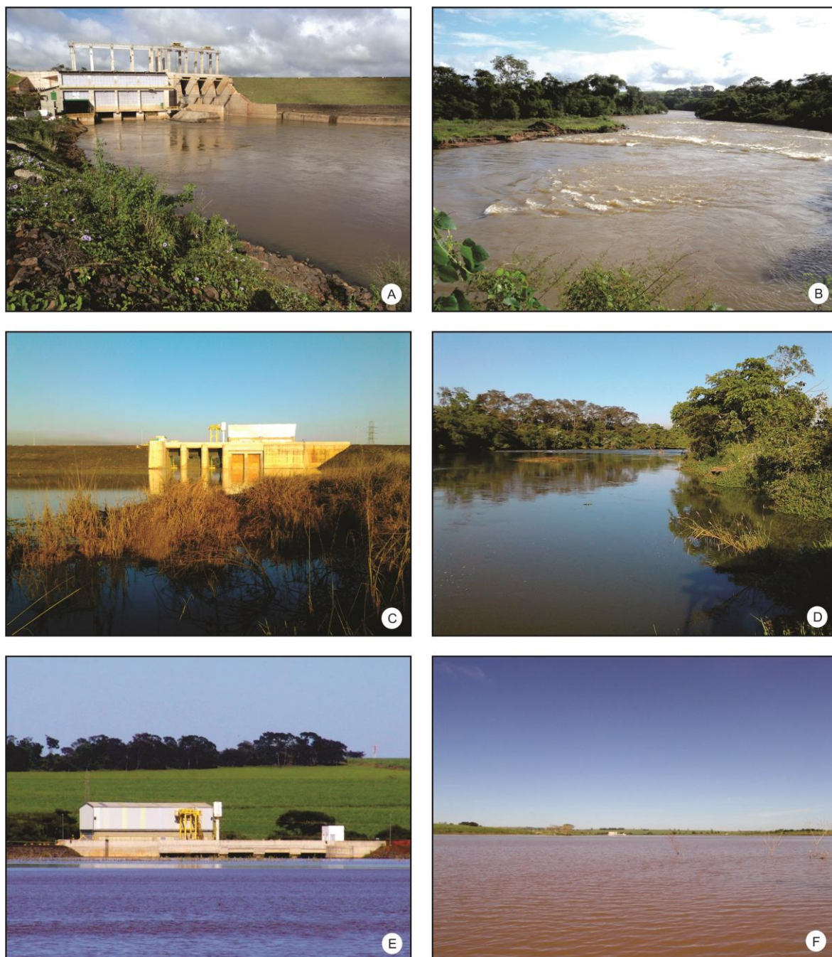
Figura 2. Três das cinco Pequenas Centrais Hidrelétricas (PCHs) em funcionamento no rio Sapucaí-Mirim, Sudeste do Brasil. A: PCH Anhanguera, B: Trecho a jusante da PCH Anhanguera, C: PCH Retiro, D: Trecho a jusante da PCH Retiro, E: PCH Palmeiras, e F: Trecho a montante da PCH Palmeiras.
