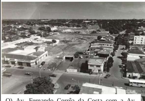
O) Av. Fernando Corrêa da Costa com a Av. Calógeras, 1987. Foto: Rachid Waqued. Disponível em: Arquivo Histórico de Campo Grande (ARCA).
