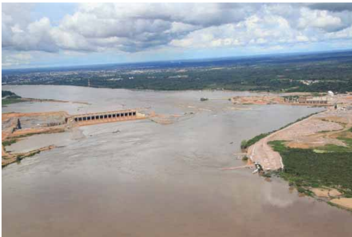
Foto 4 - Vista aérea da construção da hidrelétrica de “Santo Antônio”
