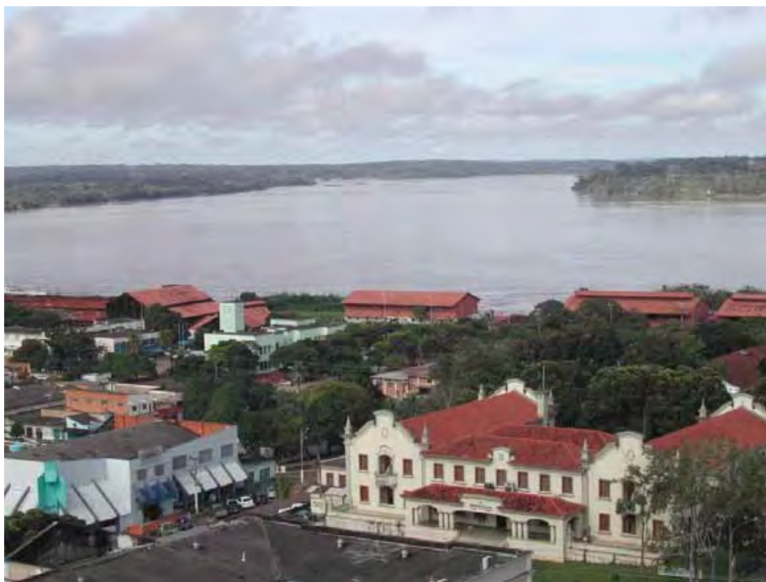
Foto 1- Vista aérea do Prédio da “UNIR- Centro” 22
