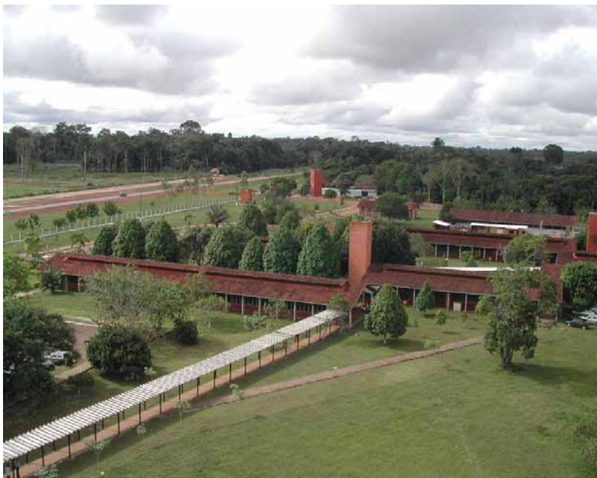
Foto 2 - Vista aérea de alguns Blocos de sala de aula de aula dos cursos de Graduação - campus de Porto Velho 23
