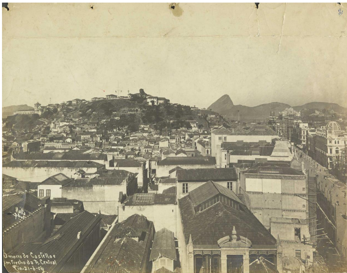
Figura 47 - À esquerda da fotografia, encontra-se o Morro do Castelo, e à direita, um trecho da Avenida Central (atual Avenida Rio Branco), já com a presença de edificações modernizadas. Augusto Malta, 1906.
