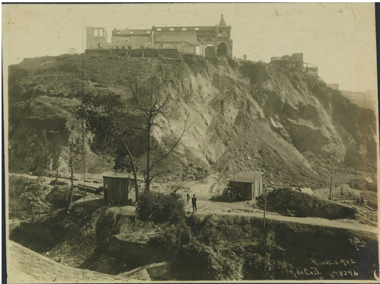
Figura 50 - Desmonte do Morro do Castelo com algumas ruínas das construções existentes.
