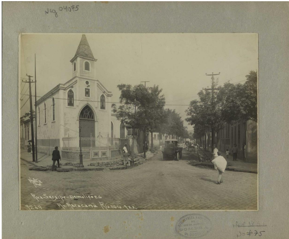
Figura 30 - Demolições na Rua Sergipe – Bairro Maracanã.
