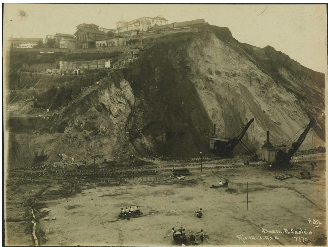
Figura 49 - Desmonte do Morro do Castelo em 1922. Fotografia de Augusto Malta.
