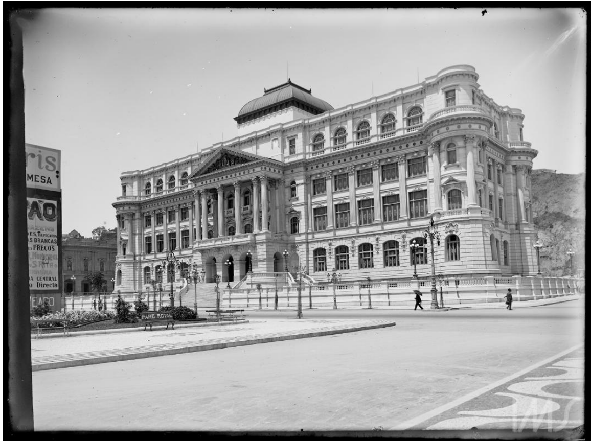
Figura 36 - Fachada e pequena lateral da Biblioteca Nacional. Marc Ferrez, 1910. Fonte: https://www.brasilianafotografica.bn.gov.br/brasilianahandle20.500.12156.17208
