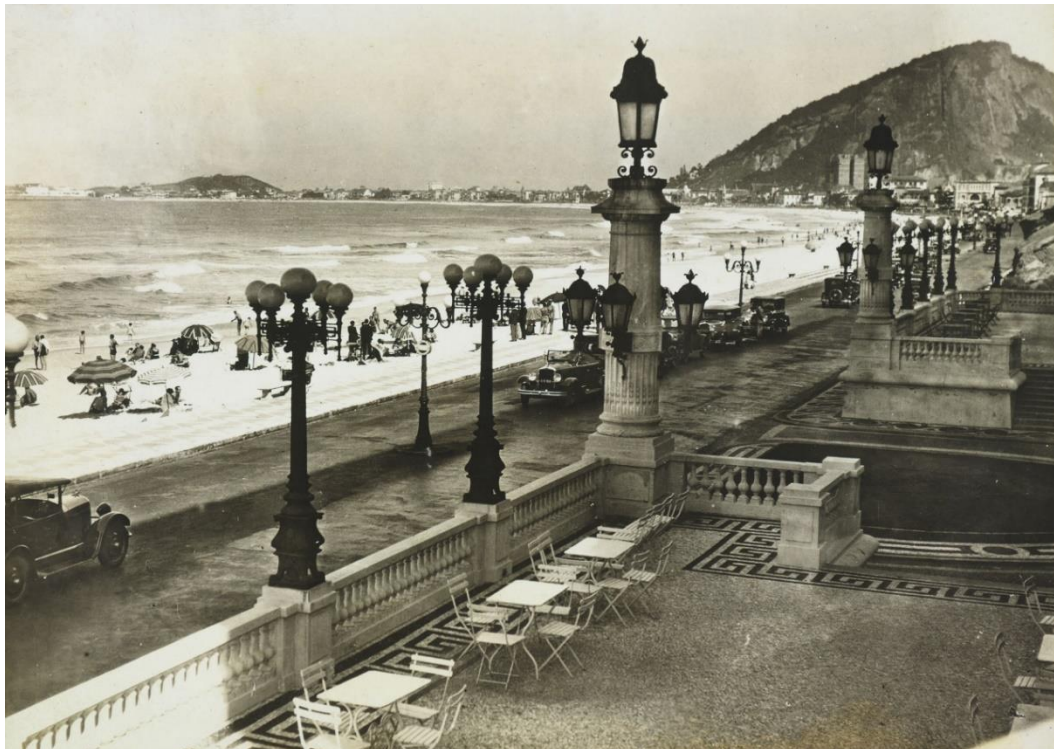
Figura 42 - Fotografia tomada do pátio do Hotel Copacabana Palace, contemplando a Avenida Atlântica, os banhistas na faixa de areia e a praia. Registro de Augusto Malta.
