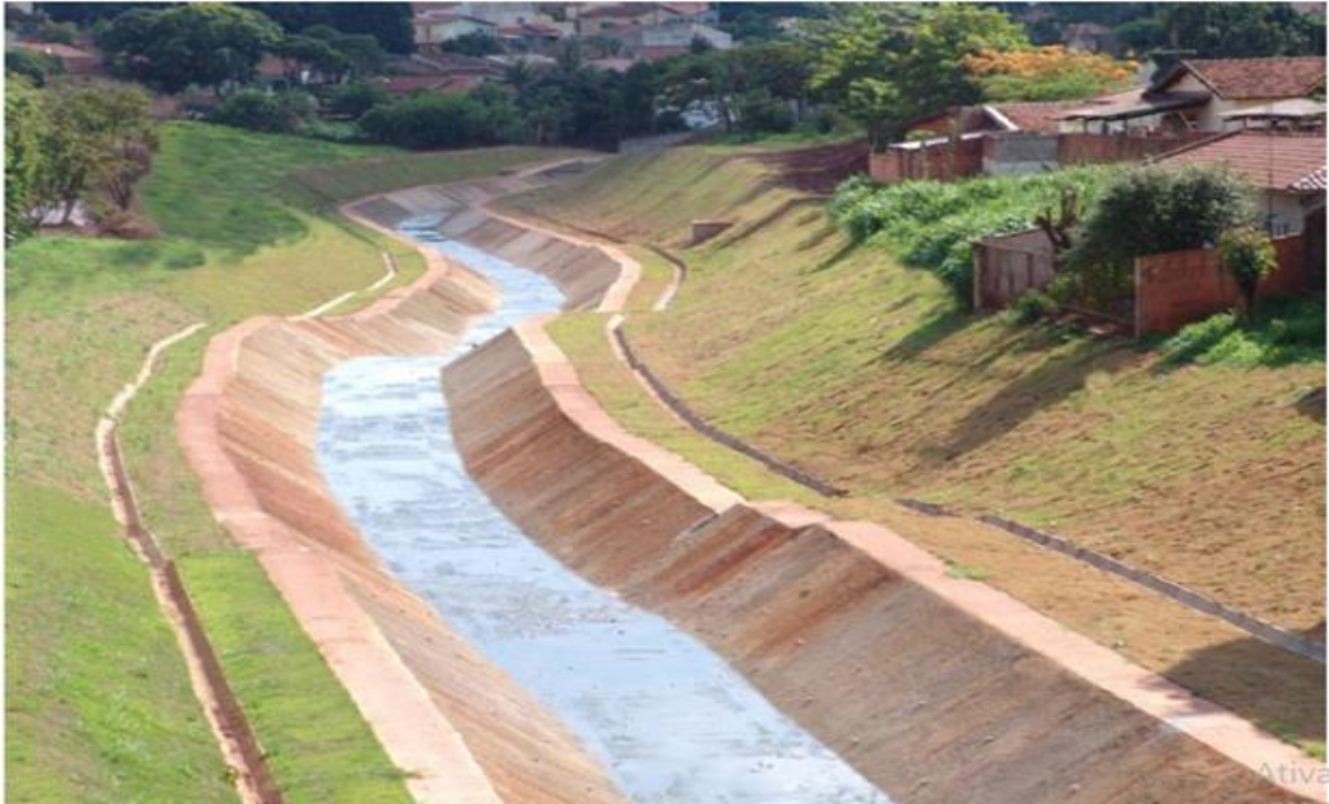
Figura 3. Córrego Monjolinho canalizado na área urbana do município de Ourinhos (SP)
