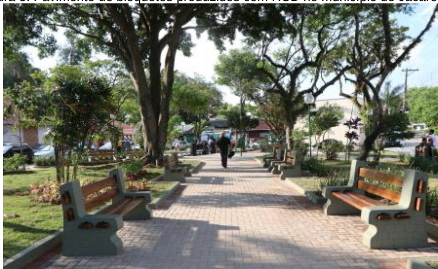
Figura 5: Pavimento de bloquetes produzidos com RCD no município de Jacareí, SP
