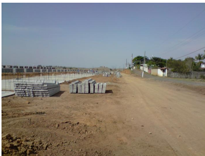
Figura 11. Local de coleta da amostra 4. Data de registro da imagem: 14/09/2010. Fonte: Autor.
