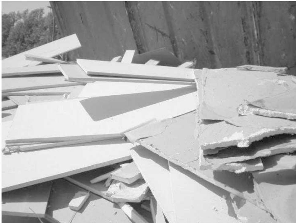
Figura 3 – Resíduos de gesso acartonado
