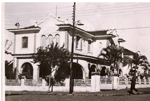
Figura 127. Residência na Av. Rio Branco.
