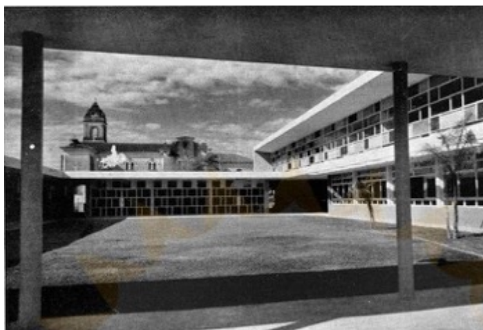
Figura 168. Vista do pátio interno. Ao fundo a Catedral, São Bento.
