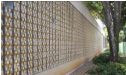
Figura 171. Paineis em ladrilho hidráulico
