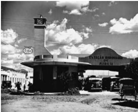
Figura 66. Fotografia da construção da rodoviária na década de 1930
