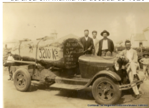
Figura 26. "Amostra" do madeiramento retirado da área em Marília na década de 1920
