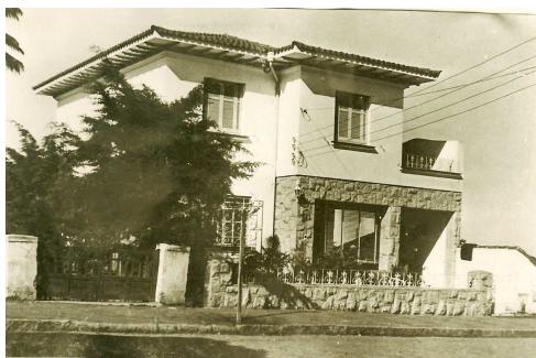
Figura 125. Residência na Av. Rio Branco.
