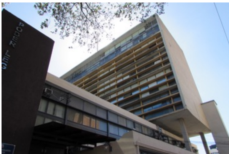
Figura 115. Fotografia atual do Paço Municipal. Destaque para os brises na fachada e o filme de proteção solar nas janelas.
