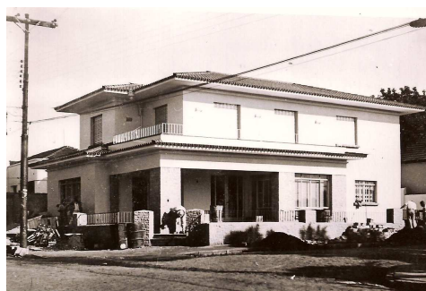
Figura 126. Residência na Av. Rio Branco.
