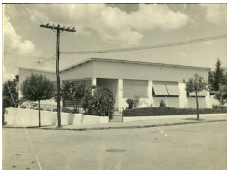
Figura 123. Fotografia da década de 1960 da residência da Avenida Rio Branco.
