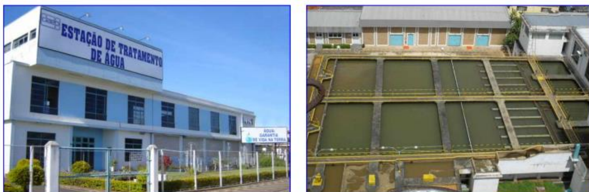
Figura 19 - Sede do DAEP e ETA.
