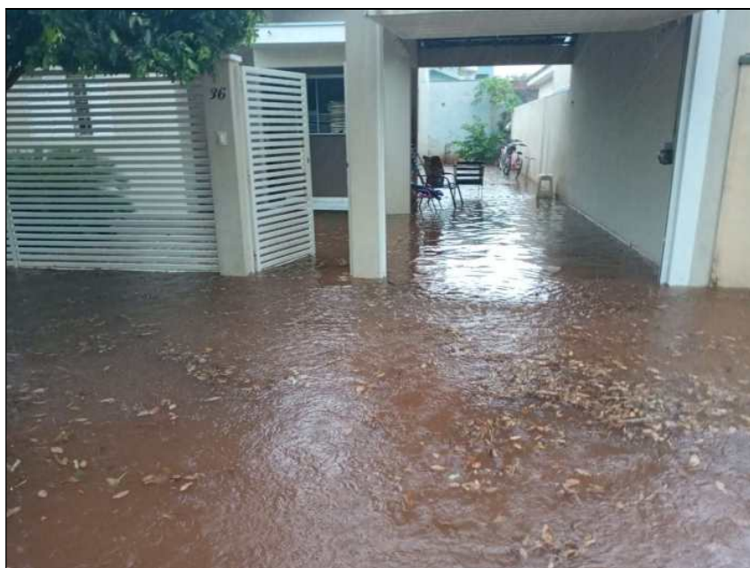
Figura 38- Registro de uma residência alagada no Bairro Residencial da Faive do dia 29/03/2020 18
