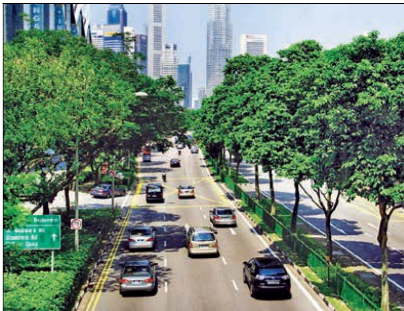
Figura 7- Canteiro pluvial entre as faixas de uma avenida em Cingapura. Fonte: Cingapura, 2018
