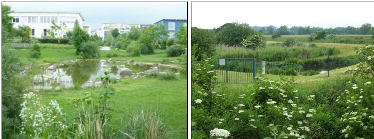
Figura 9- A- Lagoa Pluvial- – integra o sistema de drenagem naturalizado do bairro.
