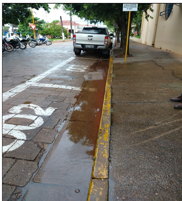
Figura 47-Registro do dia 05/01/2020- Rua São Paulo- entre o Paço Municipal e a Rodoviária. Acervo da autora
