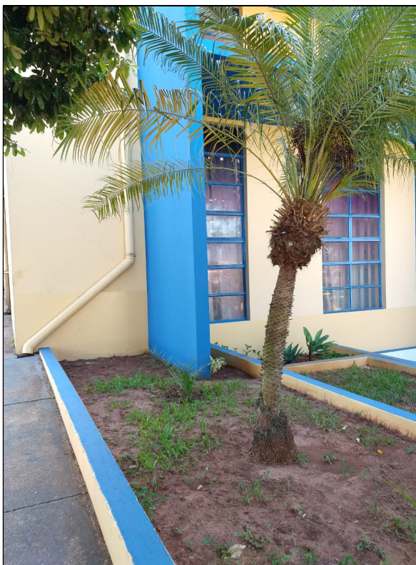
Figura 44- Detalhe do jardim e da calha que despeja as águas pluviais nas guias. Fonte: acervo da autora, 2020.
