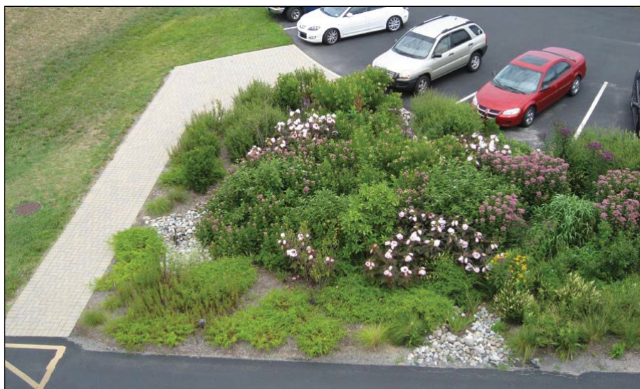
Figura 6- Jardim de chuva implantado em 2010 no Campus da UD LEWES. Fonte: Mooy,et al. 2016)
