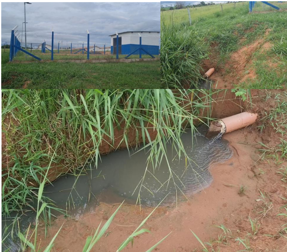
Figura 6, A, B, C - Lançamento de esgoto no curso d'água
