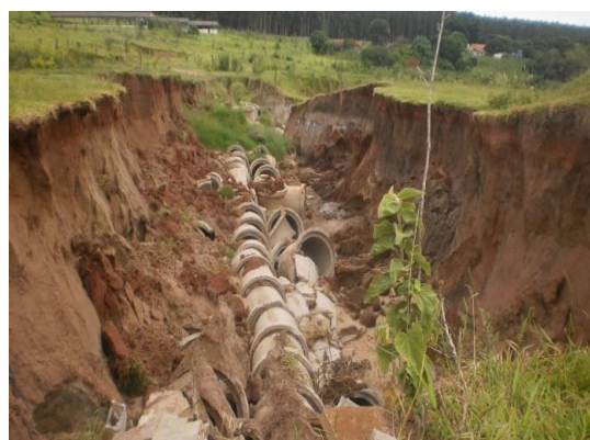
Fotografia 14: Manilhas instaladas sem sucesso. Fonte: MORAES, 2013.
