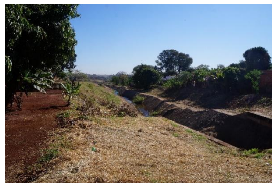
Fotografia 31: Trecho canalizado do córrego. Ocupações irregulares em ambas as margens. MORAES, 2017.
