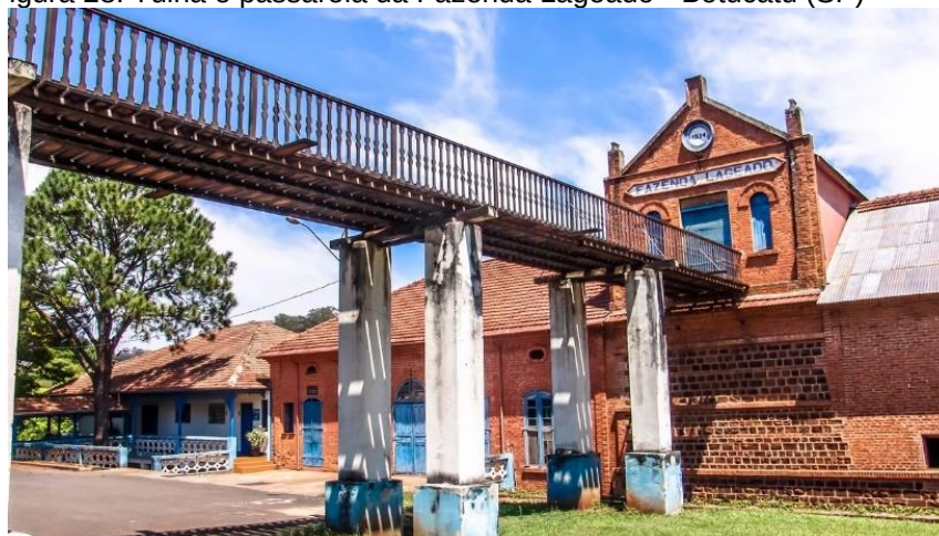
Figura 28: Tulha e passarela da Fazenda Lageado - Botucatu (SP)
