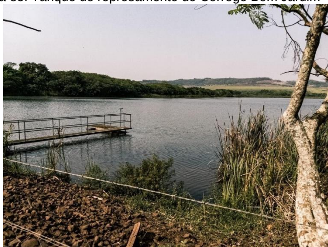
Figura 85: Tanque de represamento do Córrego Bom Jardim
