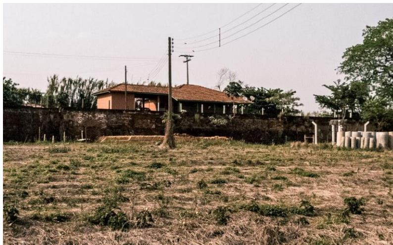
Figura 91: Casa do Administrador atualmente
