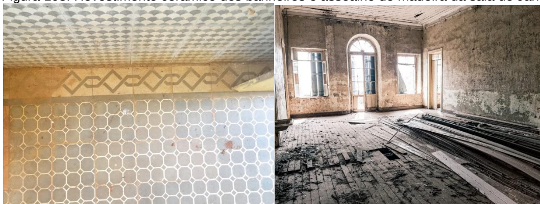
Figura 103: Revestimento cerâmico dos banheiros e assoalho de madeira da sala de Jantar
