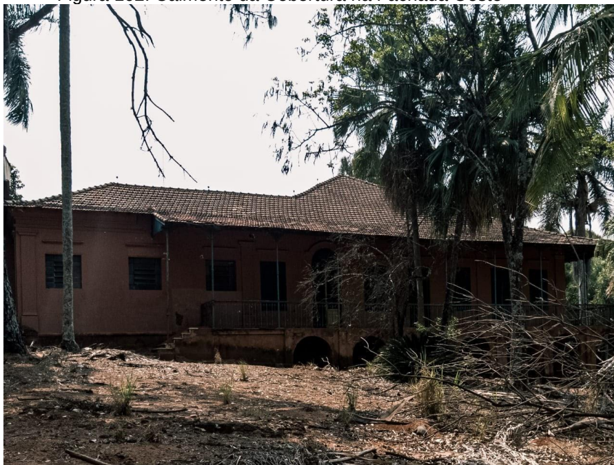
Figura 102: Caimento da Cobertura na Fachada Oeste
