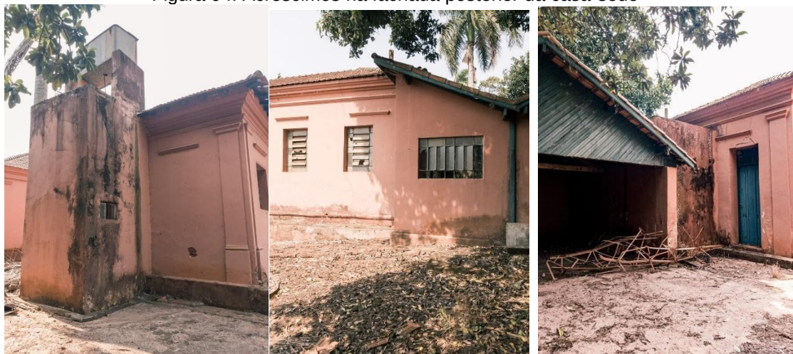
Figura 94: Acréscimos na fachada posterior da casa-sede
