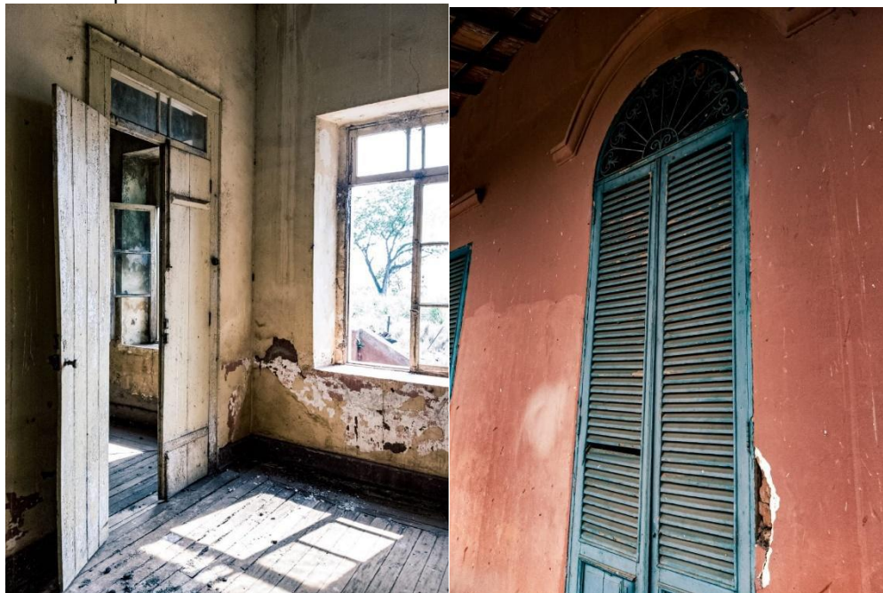
Figura 104: Aspecto das aberturas internas e Porta com elemento decorativo externa
