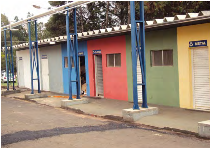
Figura 6: Abrigo externo para armazenamento de resíduos coletados no HC-FMB
