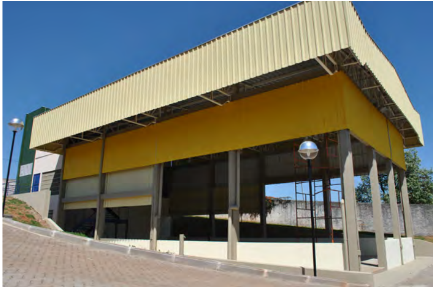
Figura 15: Incinerador em construção do HC-FMB de acordo com as normas estabelecidas
