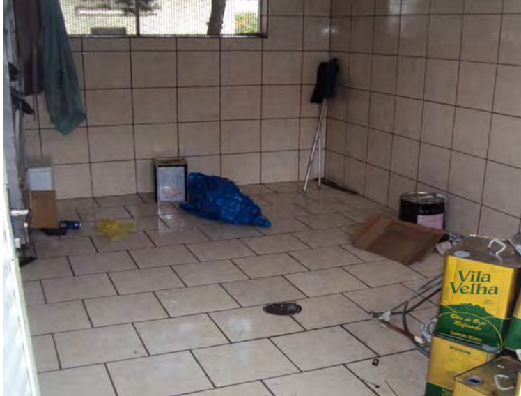
Figura 11: Interior do abrigo destinado ao armazenamento de metais
